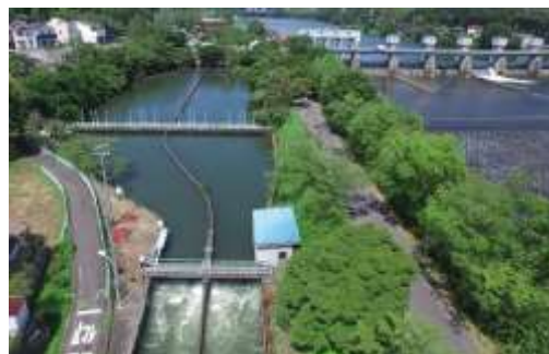
耐震対策を行う明治用水施設(豊田市)
