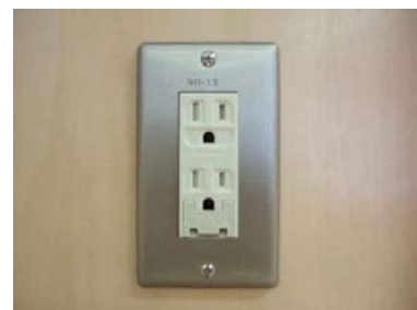
扉付きコンセント 両方の穴に同時に差し込まないと 通電しないようになっている。
