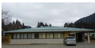
太陽光発電設備
