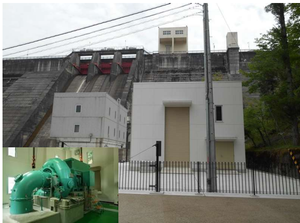
羽布ダム小水力発電所
