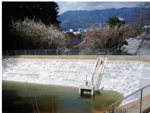
耐震整備が完了した植田の池（新城市）
