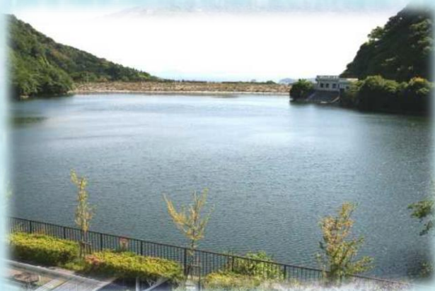
蒲郡調整池 (中心遮水ゾーン型ロックフィルダム)
