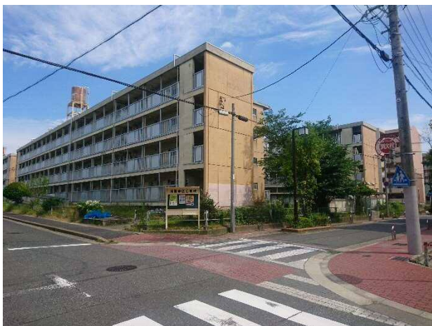
北西方より調査対象地
