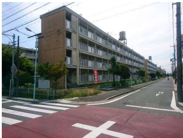
北東方より調査対象地
