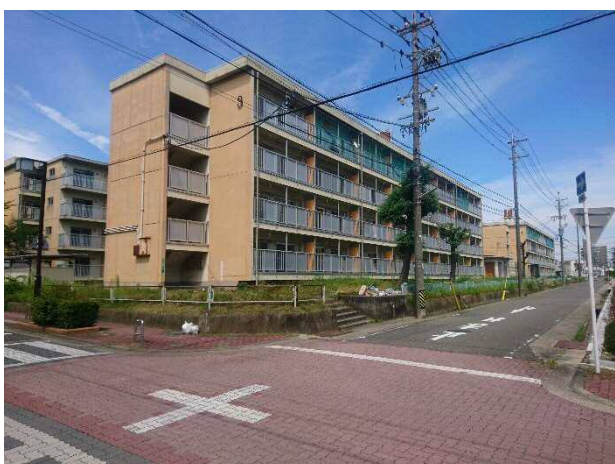
南西方より調査対象地
