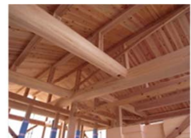
スギ材を使用した梁桁
