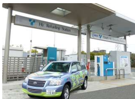
東邦ガス技術研究所 水素ステーション
