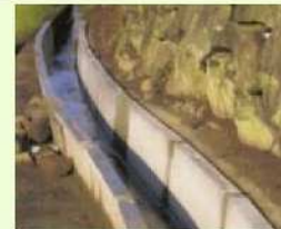
コンクリート水路の更新
