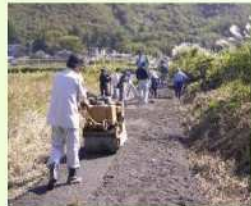
未舗装農道の舗装
