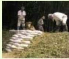
漏水箇所の補修
