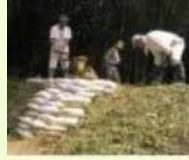
漏水箇所の補修
