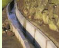
コンクリート水路の更新
