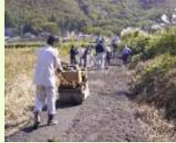
未舗装農道の舗装
