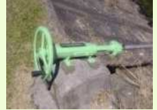
ゲート、バルブの更新
