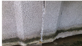
図4 ユニット接合部のコーキング処理
