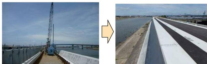
猿渡川の耐震工事状況【矢板打設】(刈谷市)
