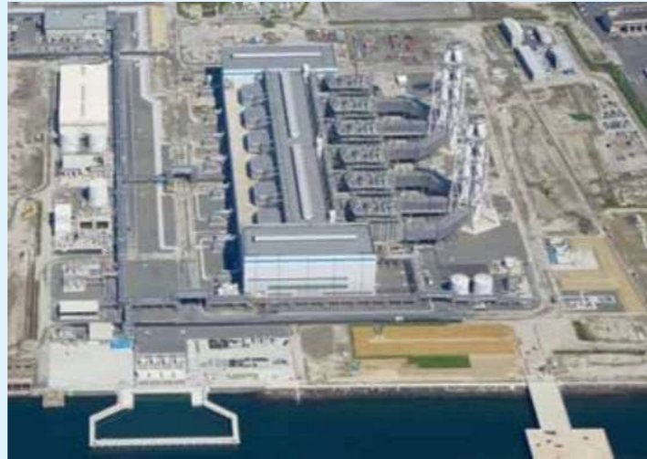
世界最高水準の熱効率を誇る西名古屋火力発電所
