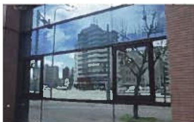
断熱フィルムを施工した窓。窓辺の作業用だけでなく、外観を後述に合わせた外観が見えづらい効果もある。
