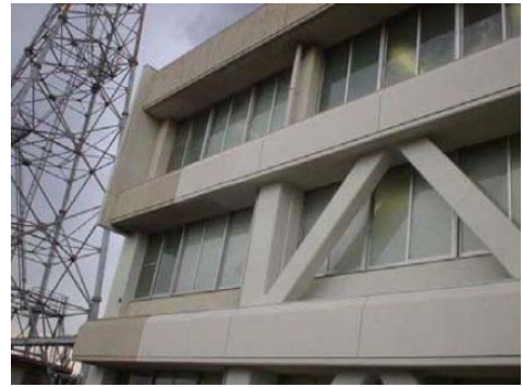
水道事務所の耐震補強状況
