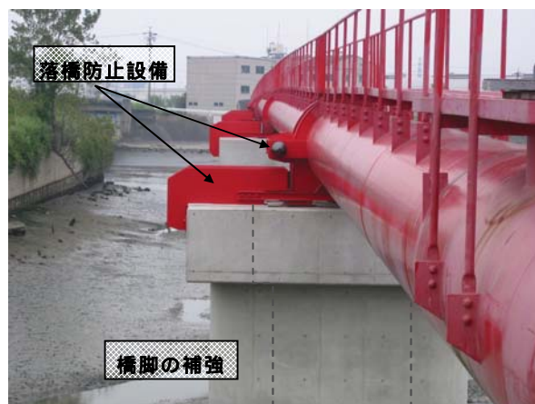
水管橋耐震補強の事例(名和水管橋)
