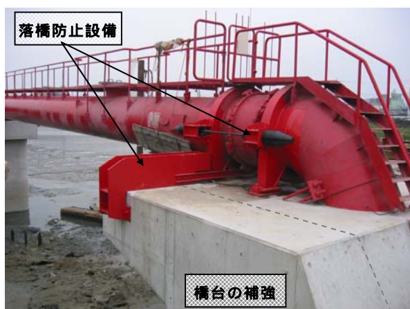
水管橋耐震補強の事例(名和水管橋)
