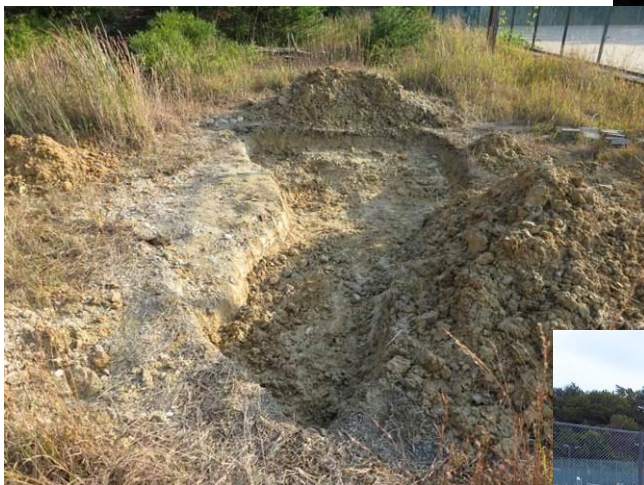
掘削完了時（11月）
