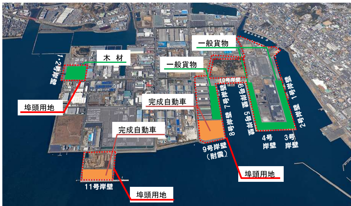
蒲郡地区の埠頭用地等の利用状況
