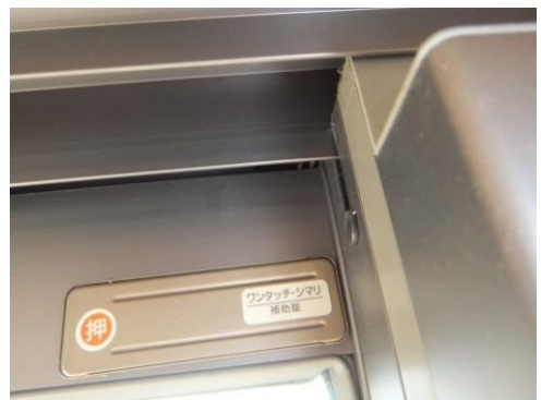
補助錠取り付け画像（窓上面）
