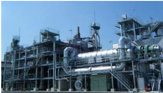
下水汚泥燃料化施設
