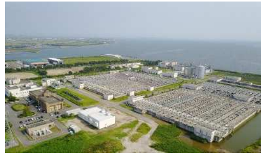
矢作川浄化センター
