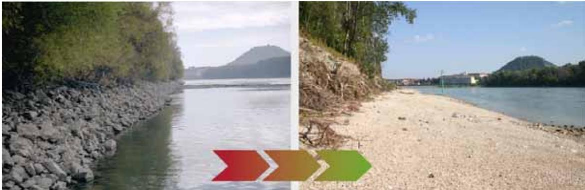
固められた川岸の再生（左：工事の前、右：工事後数ヶ月後）
