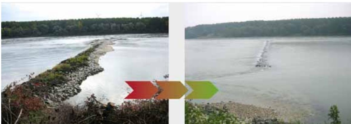
生態系を改善するために分流堰を縮小するが、航行へは影響が出ないように行った。左側が工事前、右は工事後。右側の写真が示すように、水位は変わらず、分流堰の高さを下げ、水が下流に流れやすくし、川岸に沿って魚が遡上しやすくした。
