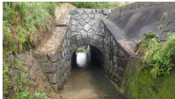
明神川逆水樋門
