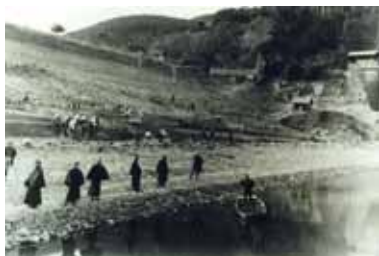
入鹿池河内堤防 明治 45 年(犬山市)
