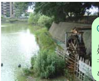
水車で汲み上げ、浄化水路を通して池に戻す （大府市 新池）
