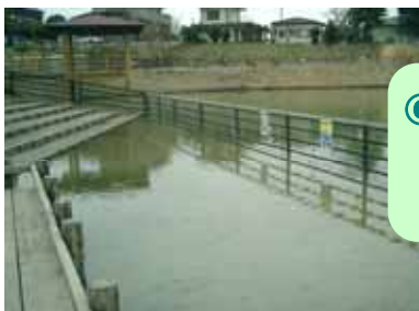
親水護岸と水中フェンスによる対策 （東浦町 田之助池）
