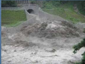
排砂バイパス(美和ダム)
