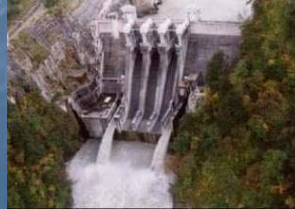
フラッシング排砂(出し平ダム)
