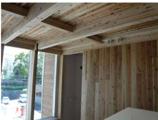
天井に現しで使用したCLT
