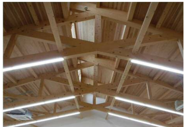
問屋棟食堂（並行弦トラス採用）
