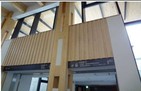
市民交流棟廊下（ヒノキ組柱、重ね梁）
