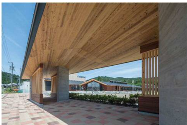
CLTの屋根で作られた正門
