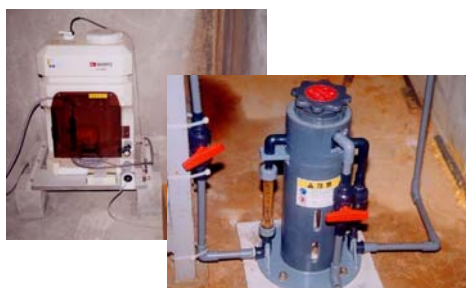
(左) 次亜塩素酸ナトリウム溶液用の滅菌器 (右) 固形剤消毒薬用の滅菌器
