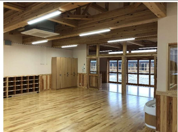
地域材を活用した集成材による保育室（床暖付）
