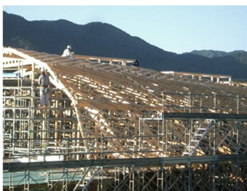
建設中の状況
