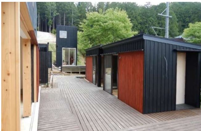
平屋棟と水回り棟のセット
