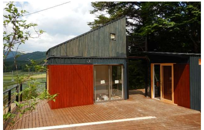
ロフト棟と水回り棟のセット
