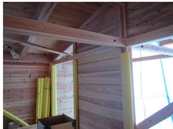
Jパネルの施工状況
