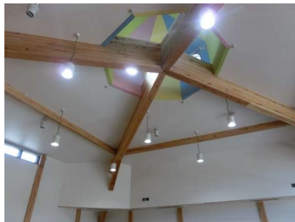
ホールの大断面集成梁
