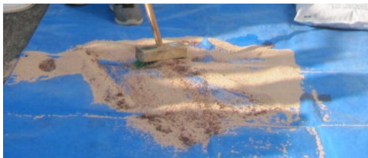
④ ブラシ等でこすり、油等を吸着させ回収する
