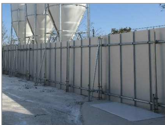
図2 金属鋼板によるパネル式防壁
