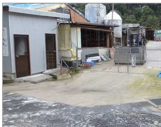
図5 衛生管理区域内の舗装
