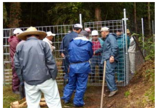
設楽町の侵入防止柵設置 (H24.10.28)
