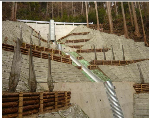
平成 24 年度山腹工施工地 (設楽町)
