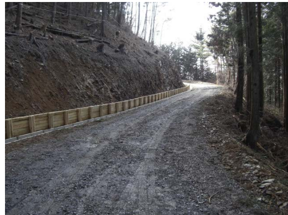
上新戸黒淵線の完了状況
