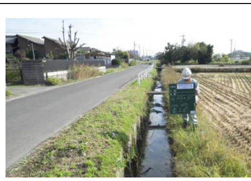
整備前の排水路
