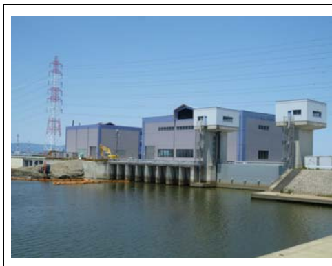
完成した建屋と工事中の堤防
