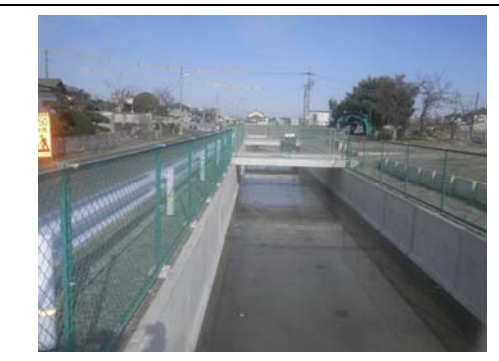
新たに整備した排水路
