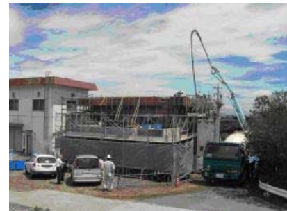
たん水防除事業一色西部地区 (排水機場整備)
