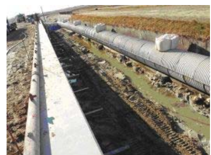
かんがい排水事業中井筋地区 （排水路整備）
