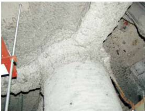
鉄骨耐火被覆
