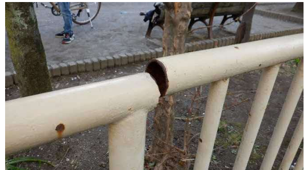
パイプ柵破断状況
