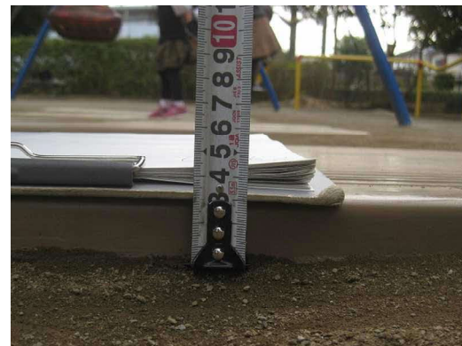
安全マット段差
