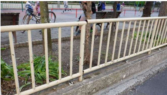
パイプ柵破断状況
