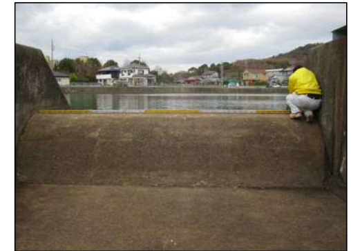
洪水吐の断面調査：徳ヶ池
