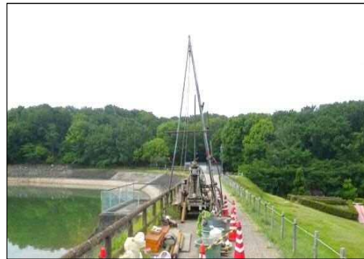
ため池堤体の土質調査：保田ヶ池
