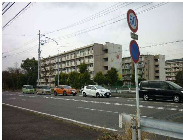
南東方より調査対象地
