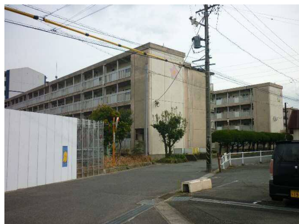
北西方より調査対象地
