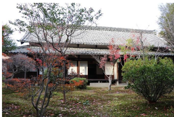
外観正面（東面）
