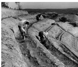
施工状況（昭和中期）
