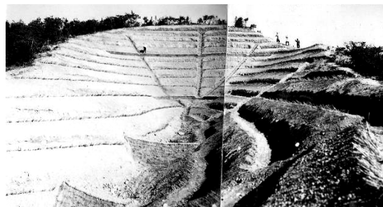
施工状況（昭和中期）
