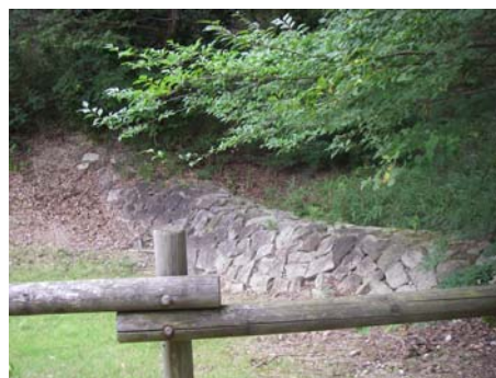
明治33年施工石堰堤（平成25年）
