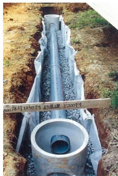
図 8-5 充填砕石工の完了
