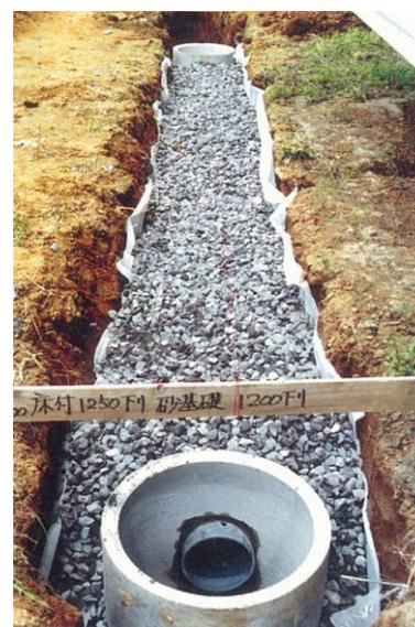
図 8-4 ます、透水管の据付
