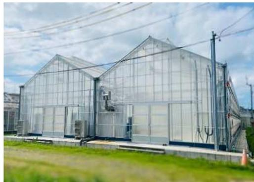
施設野菜専攻のICT温室は、令和元年3月に完成したトマト栽培専用の温室です。この温室は、日照条件を良好にするため、軒を4mと高くした「高軒高ハウス」で、デンスローの統合環境制御機「プロファーム」を導入し温度、湿度、日射量、炭酸ガス濃度など施設内の様々な環境を植物の生育に最適な環境にプログラムされています。また、パソコンによりハウス内環境を数値で把握することができます。
