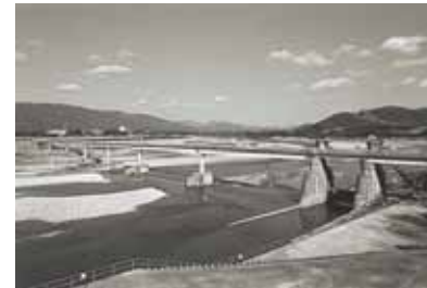
豊川用水事業により 松原用水と牟呂用水 の取水口を統合した 牟呂松原頭首工が 完成 (S43年) 10
