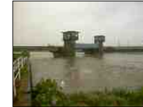
【豊川放水路ゲート操作】
