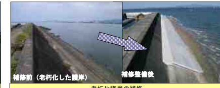
補修前(老朽化した堤岸) 補修整備後 老朽化護岸の補修
