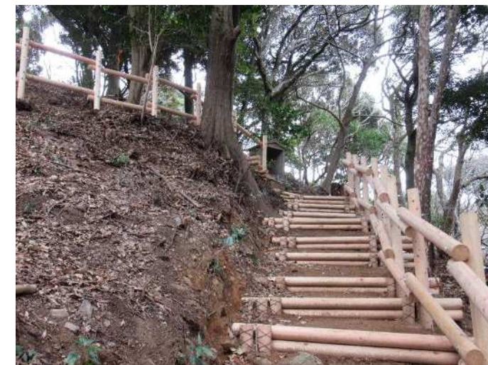
手すり等の設置
