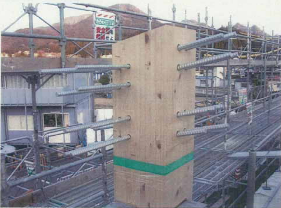
集成材組立(柱・梁の接合用鉄筋)
