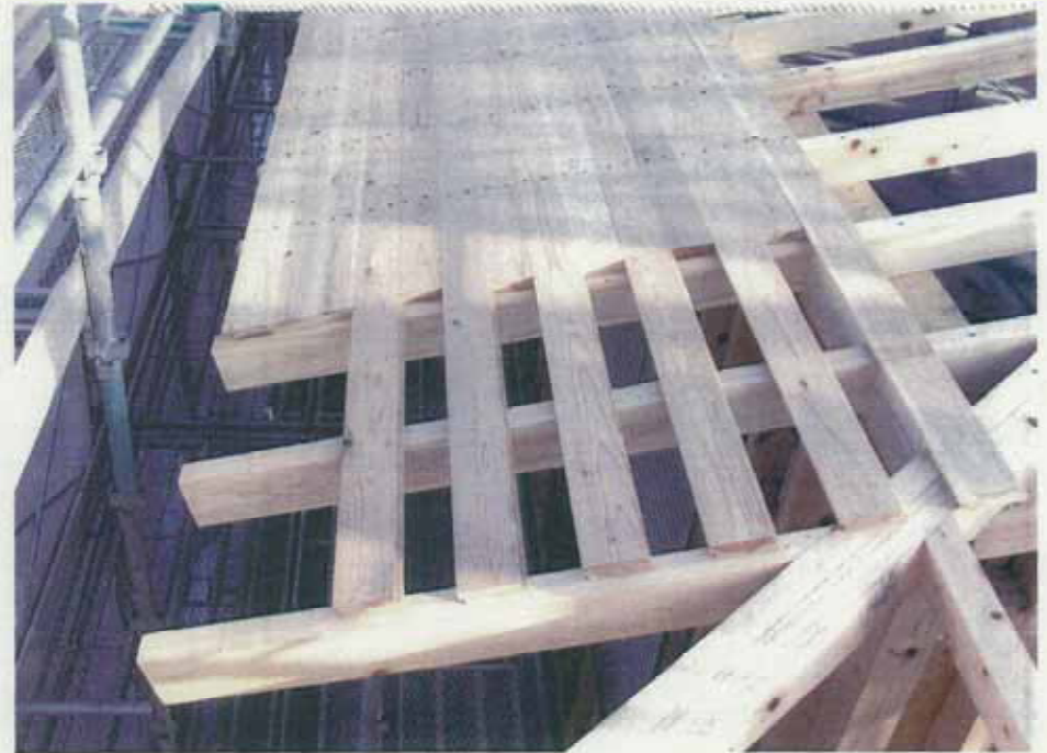
同左 軒先野地板張り
