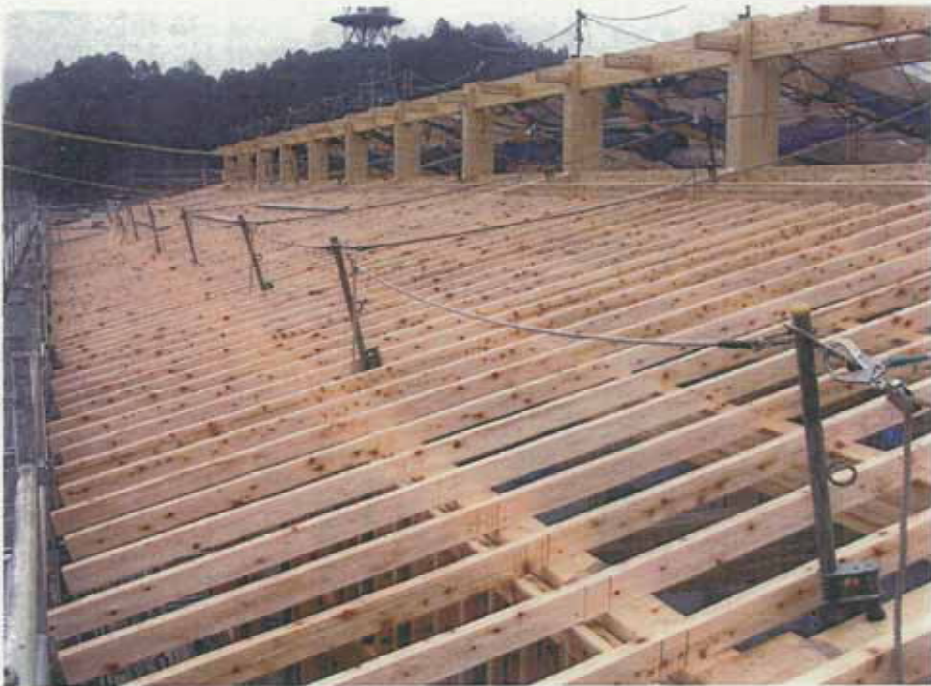
役場棟屋根(北流れ)垂木取付
