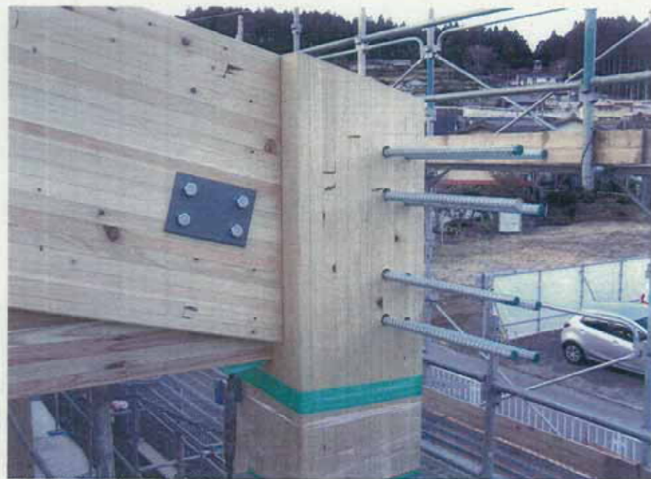
集成材組立(柱・梁接合部)
