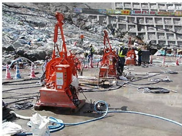
基礎処理施工状況
